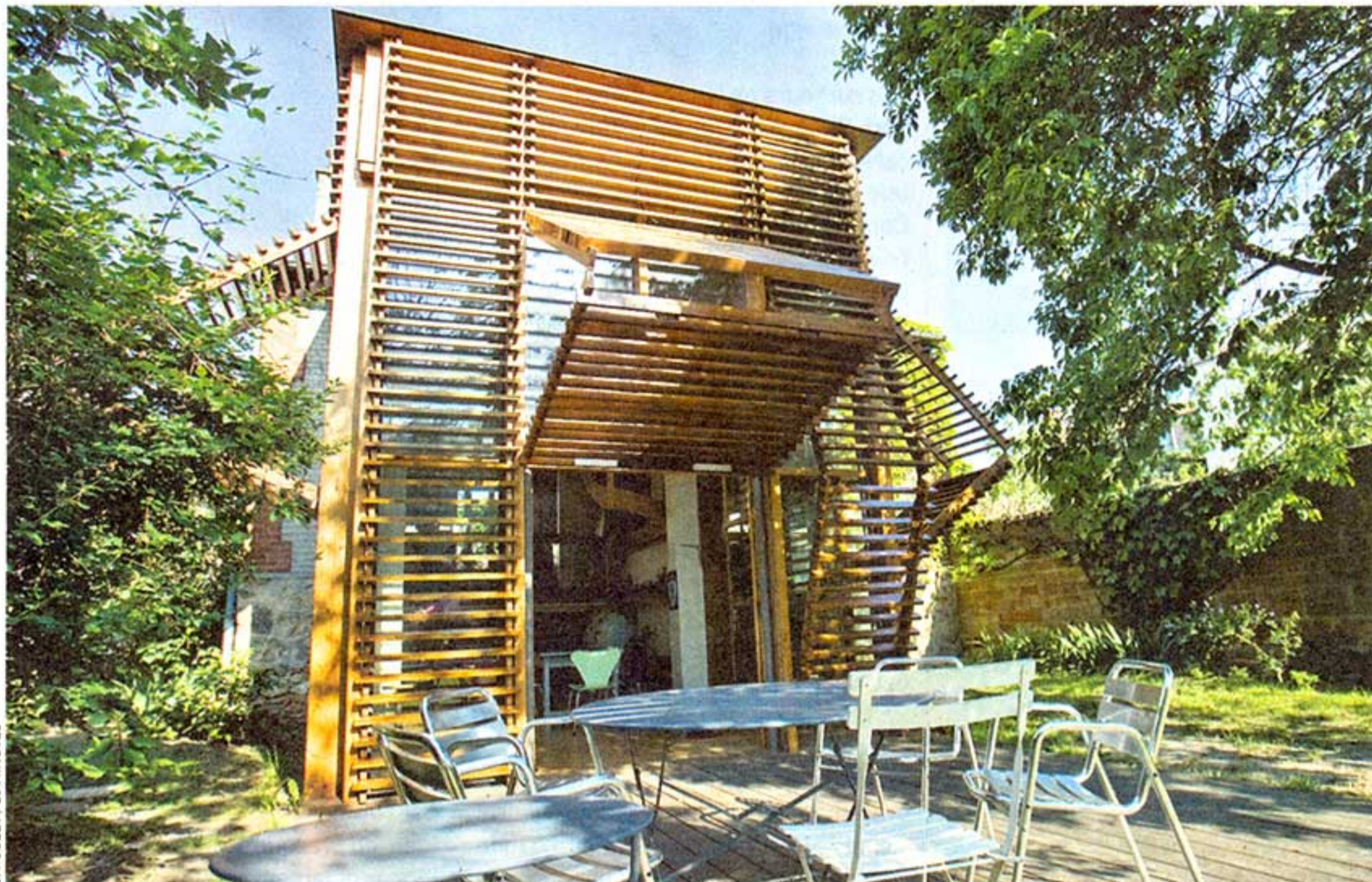
Philippe Bourillet a donné un aspect exotique à son pavillon de banlieue grâce à des volets modulables selon les inclinaisons du soleil.
